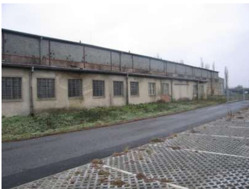
Obr. 1 Pohled na severní obvodovou stěnu obj. č. 306 (hangár H53) z exteriéru
