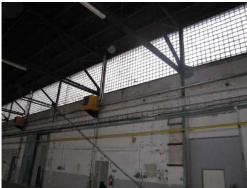
Obr. 2 Pohled na severní obvodovou stěnu obj. č. 306 (hangár H53) z interiéru
